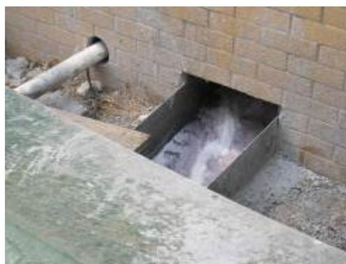
收集水磨工序产生的废液
