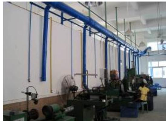
收集电焊产生的刺激性气体
