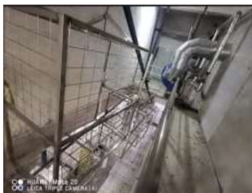
新增熱回收風管
