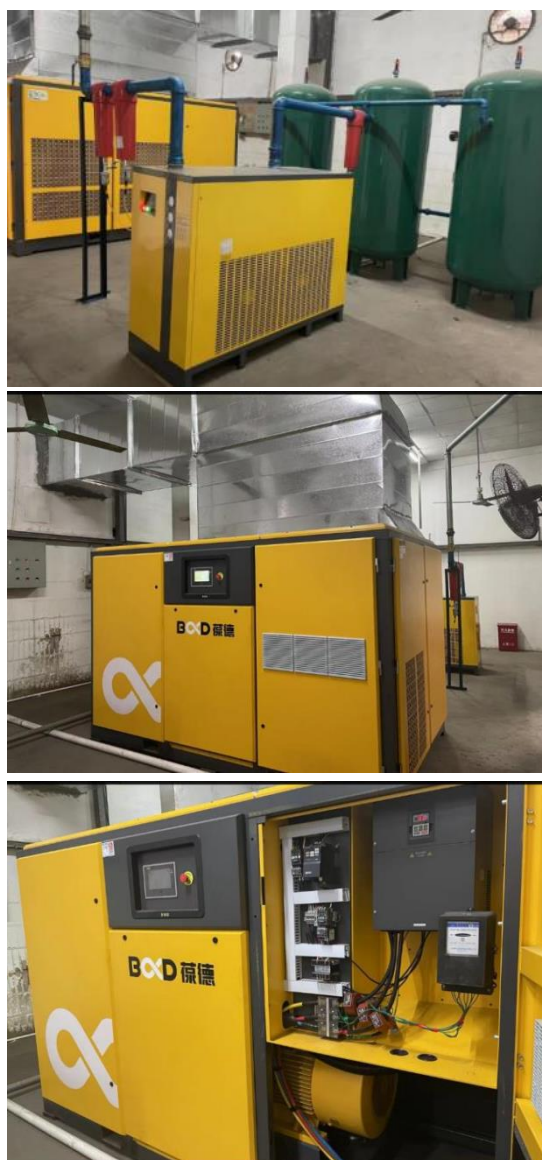
兩級壓縮螺桿空氣壓縮機
