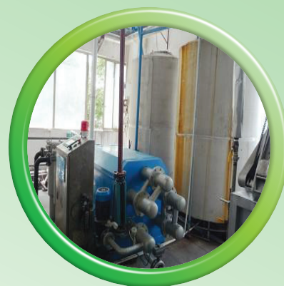
現場完成防腐工作後的 SAF池外觀
