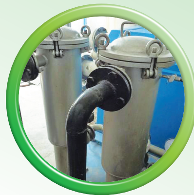
現場完成曝氣設備及填料支架 安裝後的SAF池外觀
