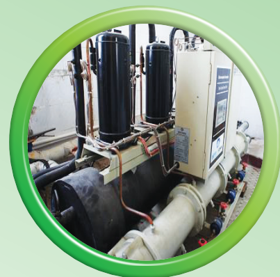
中央空調系統的冷凍水主機
