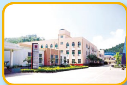
廣東嘉寶莉化工(集團)有限公司外貌
