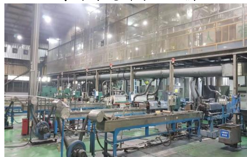
注塑車間廢氣收集
