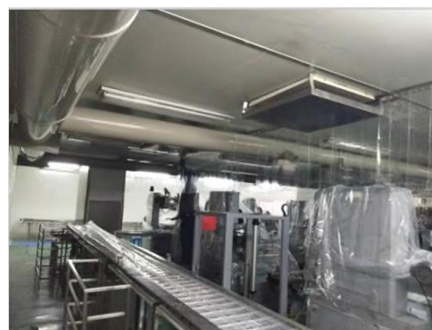
綠油絲印車間內風管
