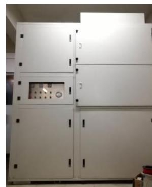
沸石吸附配合布袋過濾廢氣處理設施
