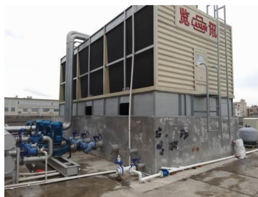
大型冷卻水塔（所有注塑機及共用）
