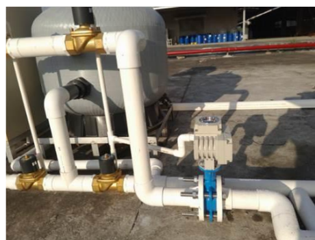
反沖洗式砂缸及出入水管道
