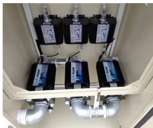
冷卻水塔安裝電磁波技術
