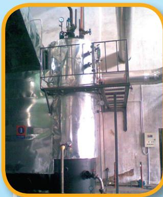
热管式锅炉余热蒸汽发生器
